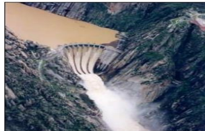
Central hidroeléctrica de Aldeadávila (Salamanca)
